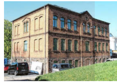
Die denkmalgeschützte, ehemalige Grundschule am Park in Pößneck wird aufwendig saniert.
